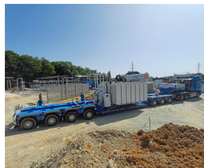
Arrivée et mise en place du transformateur de 36 MVA sur le chantier du poste source express.
