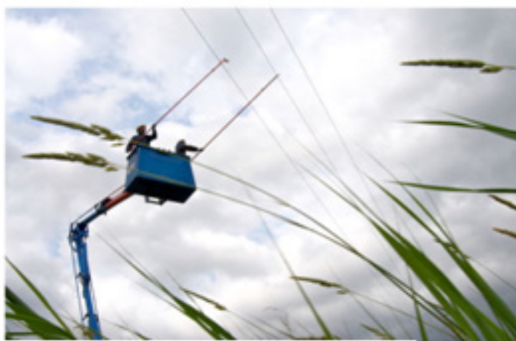
Pose de balises avifaunes
