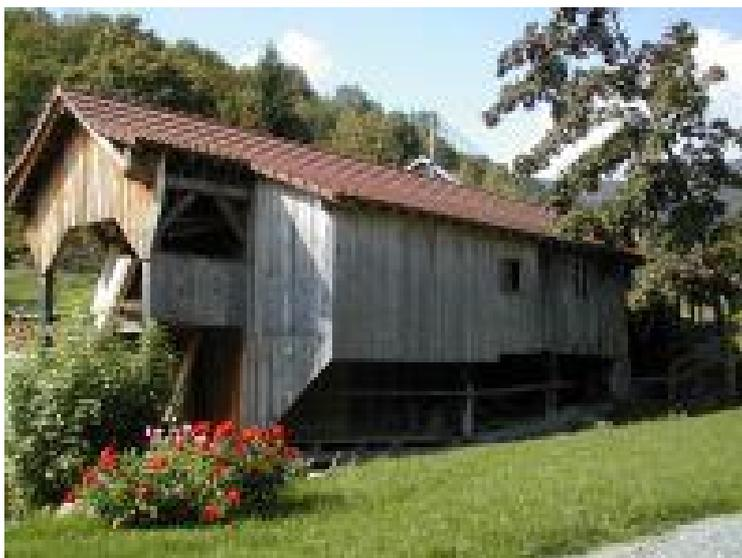
Cette scierie est une scierie hydraulique qui fonctionne grâce à une « roue à augets ».
