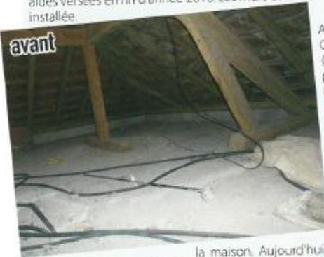
Au regard de l'étiquette énergétique G constatée avant travaux (consommation énergétique de plus de 1000 kWh/m<sup>2</sup>.an), le cabinet URBAM CONSEIL a préconisé d'isoler les combles et les murs et d'installer une VMC performante. Le projet permet un gain énergétique de 68%, pour atteindre une étiquette F après travaux (et une consommation énergétique de 363 kWh/m<sup>2</sup>.an).
